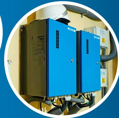
**El LORENTZ PSk es un sistema de bombeo de agua con energía solar para aplicaciones medianas y grandes (5-100kW). El PSk ofrece lo mejor de ambos mundos, ya que se alimenta de energía solar siempre que sea posible y se combina con fuentes de energía alternativas sólo cuando sea necesario.**
